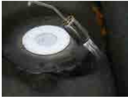
2. Werkseitigen Bitumenkragen des Ablaufs mit der bauseitigen Bitumenbahn verschweißen
